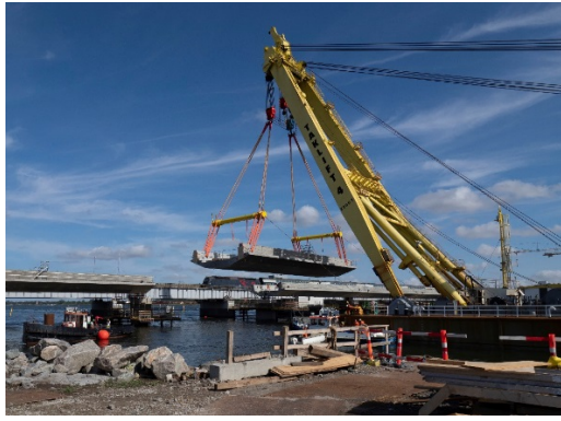
Montering af broelementer med spor i drift
