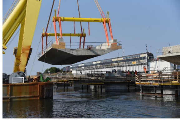
Montering af broelementer med spor i drift
